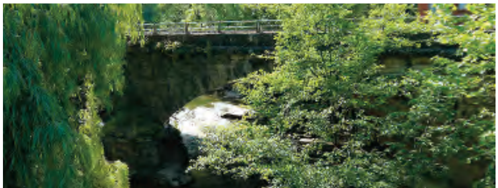
El puente del "Rey" sobre el río Besaya.
